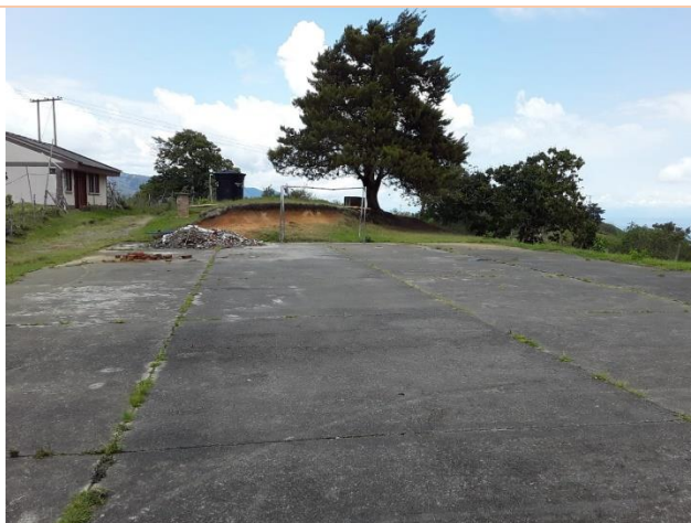
Cancha Corregimiento San Francisco
